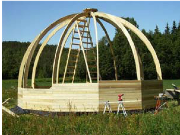
Rolf in Norwegen hat eine ähnliche Idee erhalten – Foto vom Bau 2008
